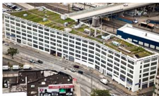
Фиг. 4. Фермата на покрива „Игъл Стрийт” Бруклин, Ню Йорк
